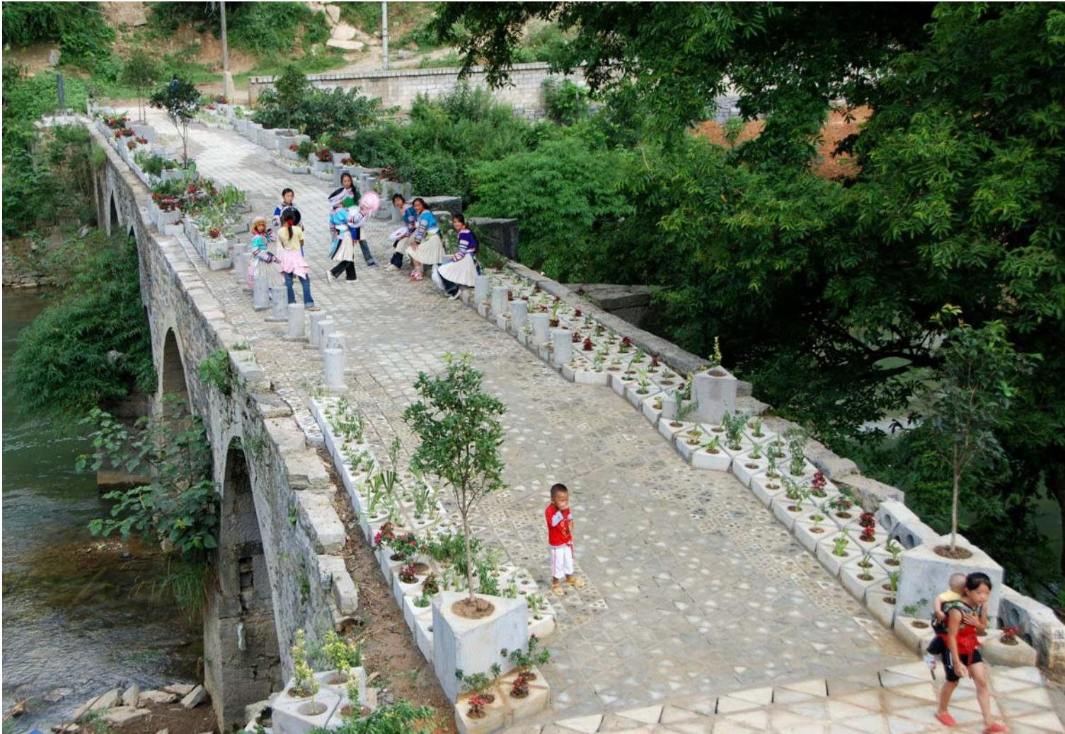
该项目展示了结合文物保护和当代设计的一个做法。古桥修复工程是一个为期两年的计划，为拥有300年历史的古桥进行重建及桥面修复。此项目最大的挑战是如何在现代农村语境下把这道古桥活化，为其重新赋予历史重要性。该项目融合了历史悠久的石造建筑和现代的预浇铸混凝土技术。拱门的修补和桥面人行道的铺设均用上了预浇铸混凝土。通过与当地工厂合作，桥的铺面定制成不同大小的砌块，作为绿化铺砖和桥面座椅。通过把当地技术创新，整座大桥就这样变成了附近居民新的公共空间。
