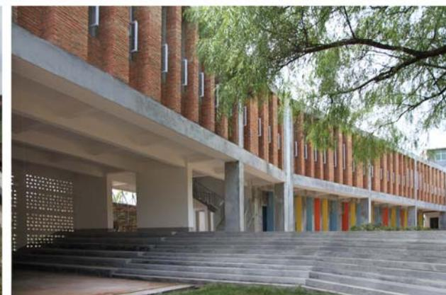
为应对农村地区的广泛拆毁，此项目提出了回收旧建材以循环再用于兴建新校的策略。这项目要求兴建新的教学楼来代替现存的旧教学楼，并增设新的教学功能。对于被毁坏的旧建筑，我们的计划是将其砖块碎片重新利用，作为绿化屋顶的育苗基质和隔断材料。同时，我们从其它拆建现场收集那些已经停产的青砖，利用它来建造一面镂空花墙和作为学校铺面的材料。这个项目示范了如何在一个可持续性的新学校原型工程中循环利用旧建材。
